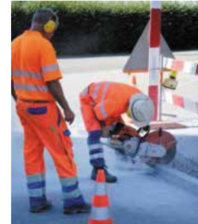
Eine Rampe erstellt
