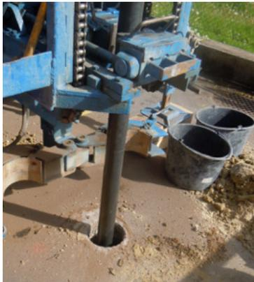
Zur Planung gehörten auch Abklärungen zur Beschaffenheit des Bodens und der Möglichkeit, erfolgreich Erdwärme zur Energiegewinnung für das neue Heim zu nutzen. Deshalb durften bereits vor offizieller Baubewilligung Probebohrungen durchgeführt werden.
